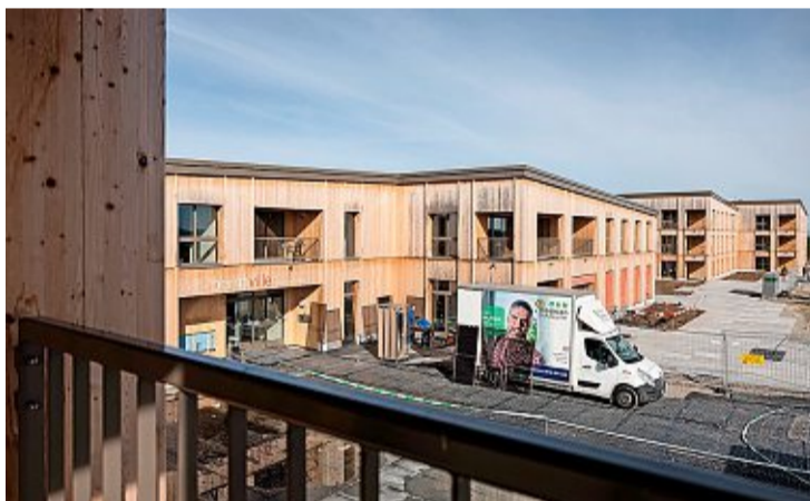
Die Aussenarbeiten am Neubau laufen zwar noch, gewohnt und gearbeitet wird aber trotzdem schon.
